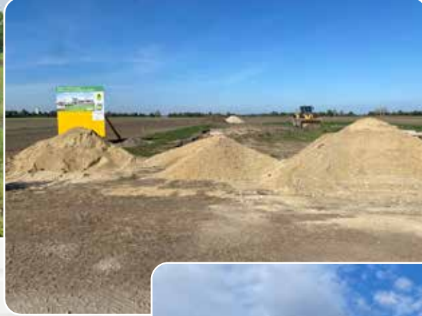
Der erste Bagger rollt an am 02.10.2023
