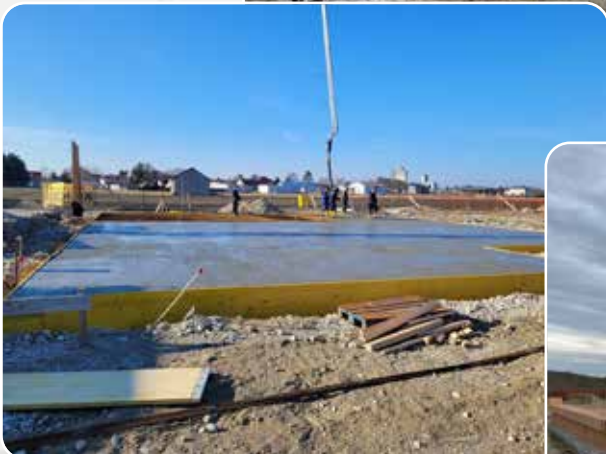
Aufgrund der Witterungen wurde erst am 30.01.2024 mit der Bodenplatte begonnen
