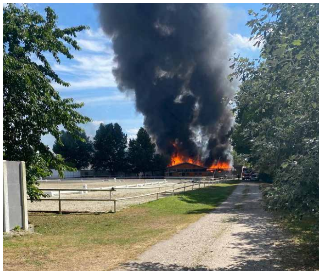
Beim Eintreffen schlugen die Flammen aus dem Dach.
