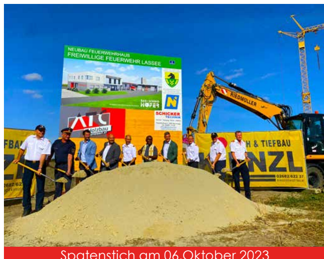
Spatenstich am 06.Oktober 2023
